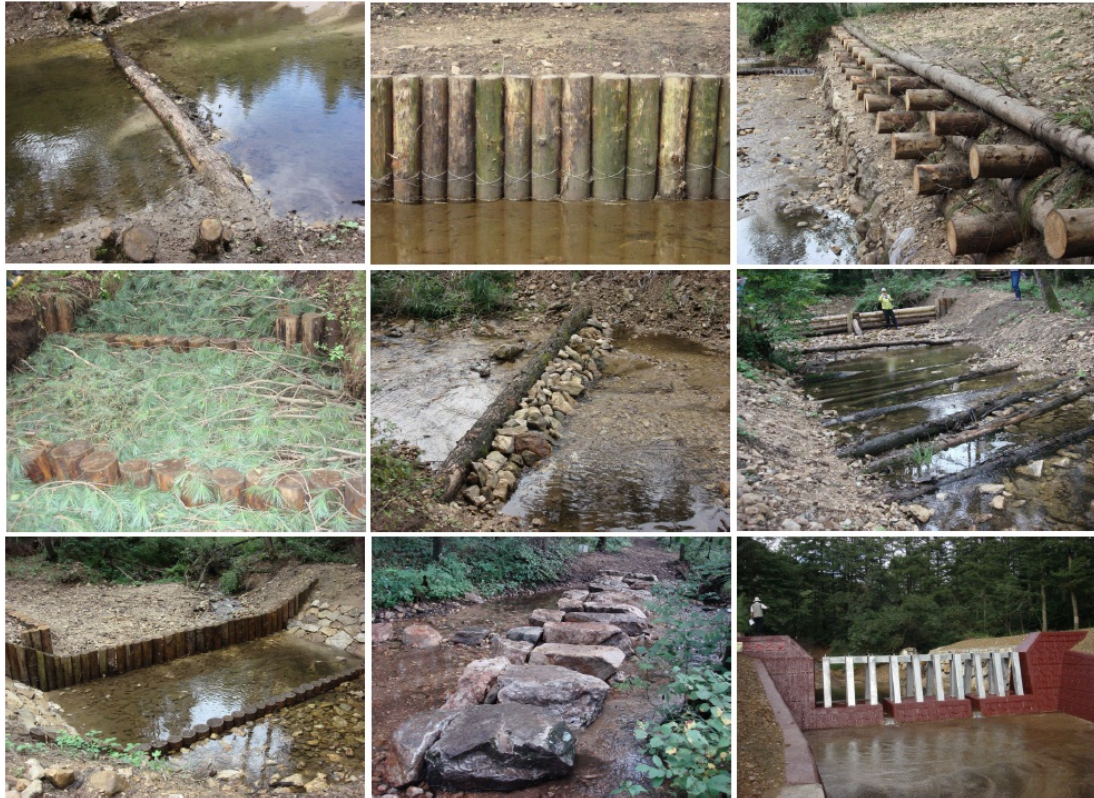
図-1. 事業地における間伐材と石などの自然素材を活用した構造物の施工状況
