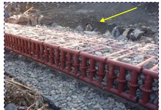
図-2 鋼管枠下流洗掘防止対策の鋼製布団かご設置状況
