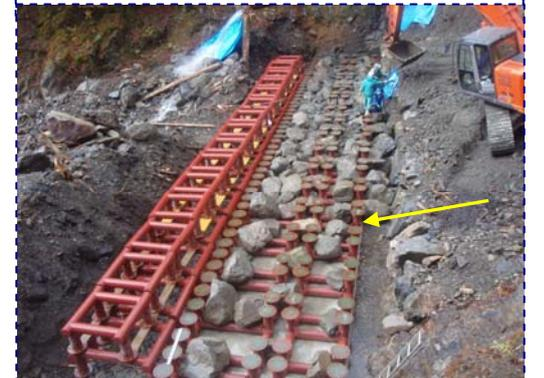
図-3 鋼管枠内の礫配置概念図(上:側面図)と施工中の下段鋼管枠内の礫配置状況(下)
