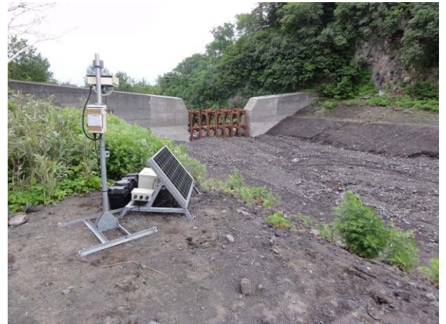
写真 1 設置地点の状況（えん堤上流から下流を望む）
