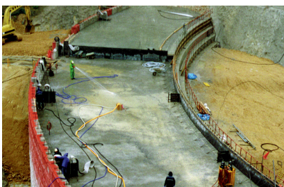
図-1 拡張レーヤ工法施工例
