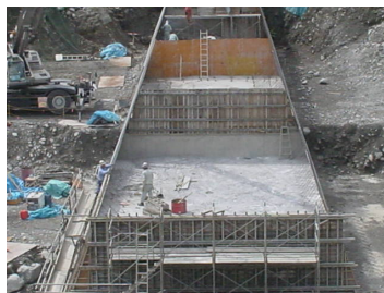
図-2 一般型枠による横継目例
