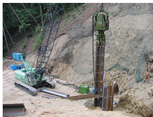
図-3 地中部鋼矢板の打込み状況
