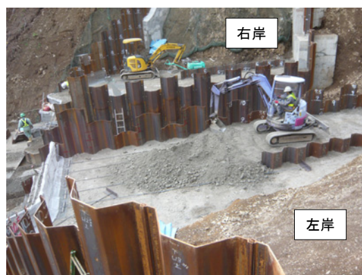
図-5 地上部ダブルウォール堰堤の施工状況
