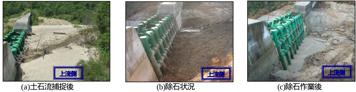
写真-2 鋼製透過型砂防堰堤 (B 型) の除石状況
