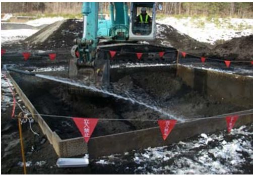
写真-1 ソイルセメント試験施工実施状況
