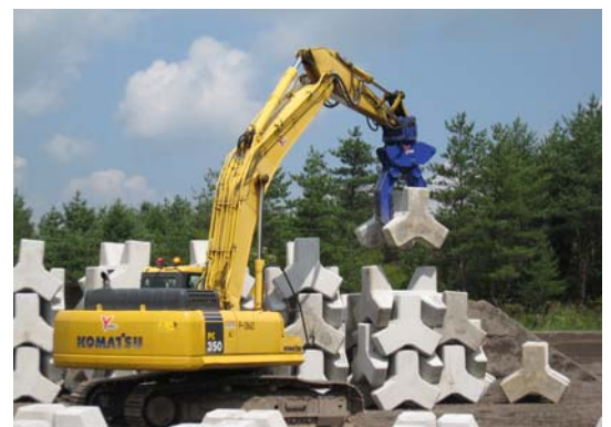
写真-2 無人化施工の実施状況
