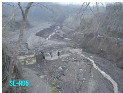
写真-5 巨礫衝突による破損(1)
