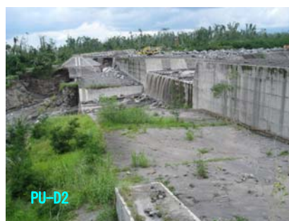
写真-4 袖部土石流越流による損壊
