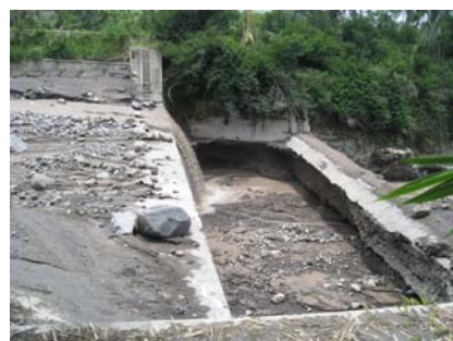
写真-6 巨礫衝突による破損(2)
