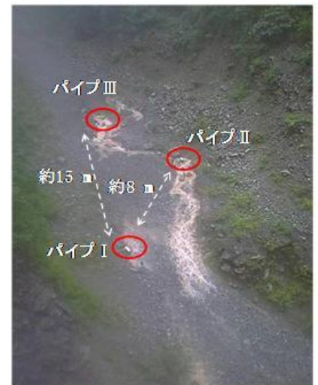
写真－1 パイプ流発生状況 （2010年8月9日 9:00）
