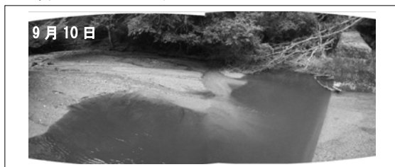
写真2 台風9号出水後の2号堰堤堆砂域
