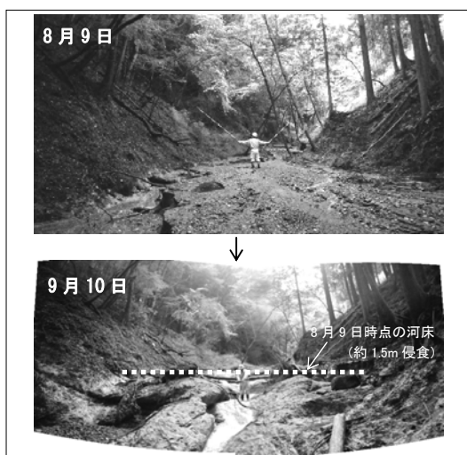
写真3 台風9号出水による土砂移動状況 [B区間]
