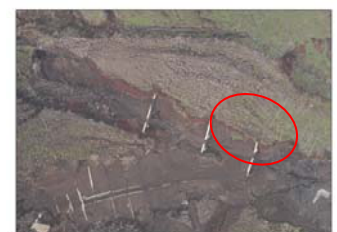
図 11. 金曾沢の砂防堰堤状況
