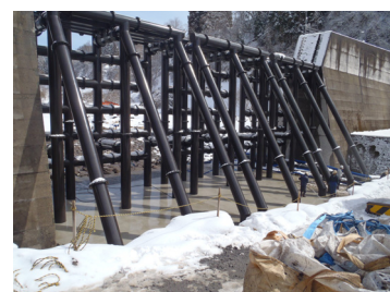
写真7 鋼製部の組立完了
