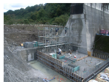
写真6 一次コンクリートの打設
