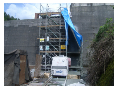
写真3 コンクリート切断状況
