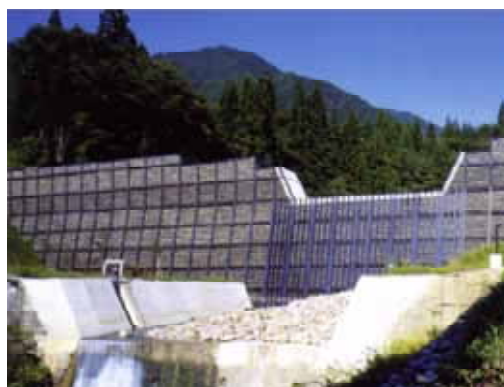
写真-1 鋼製枠砂防堰堤
