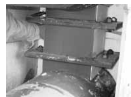
写真3 ボルト取外し状況
