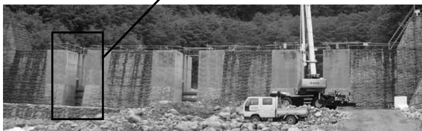
写真1 扇沢鋼製砂防シャッターの概要
