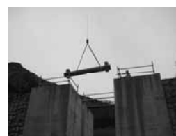
写真4 横棧取外し状況
