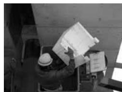
写真2 発泡スチロール取外し状況
