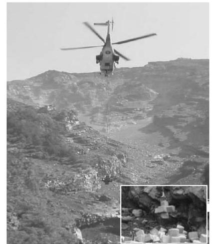
写真-3 ヘリコプターによるブロックの設置状況
