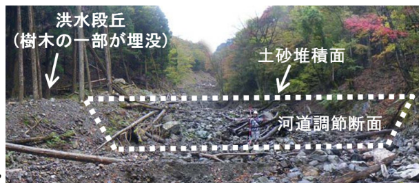
写真-1 河道調節断面
