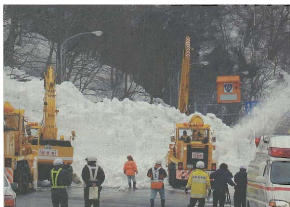
写真1 国道112号に堆積した雪崩 （山形新聞 平成23年2月28日）
