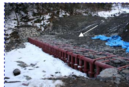
図-5 鋼管枠工施工後(2011年2月)
