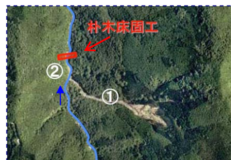
図-1 被災後の調査地と施工箇所 (①: 2005 年深層崩壊, ②: 堆積域)
