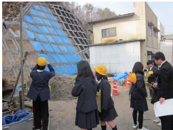
写真1 現地調査-のり枠による対策工事観察
