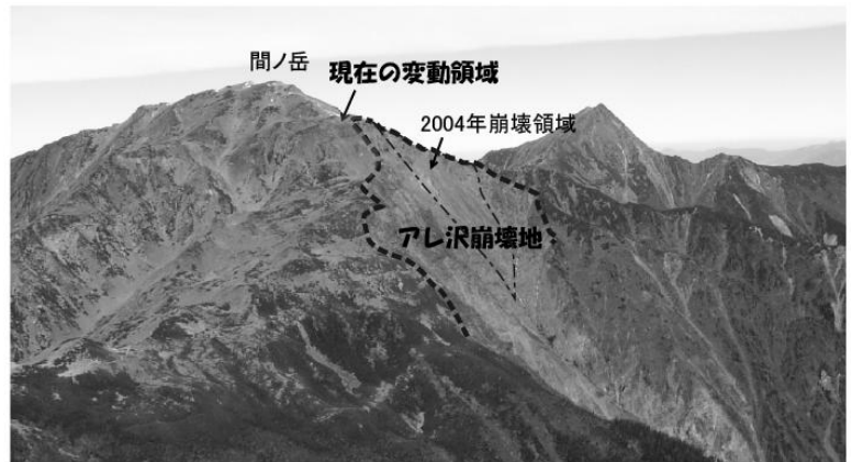
図-1 アレ沢崩壊地の全景(北を向いて撮影)
