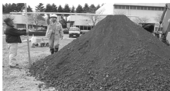
図-4 センサーを埋設した盛土(高さ185cm)
