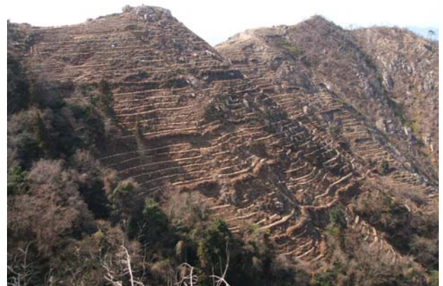
写真-2 山火事跡地に施された山腹緑化工
