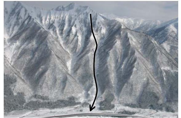
図 2 土樽雪崩発生現場（長岡国道事務所提供）
