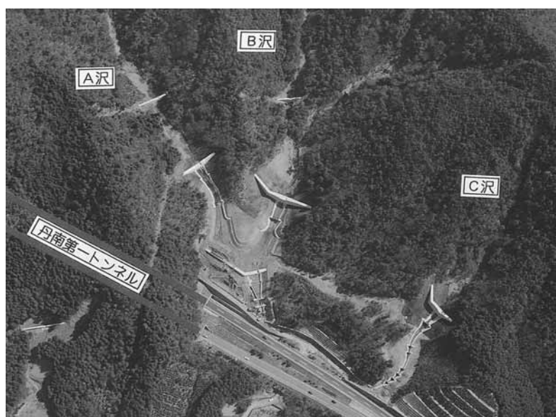
写真-2 災害対策実施状況
