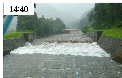
写真-3 水無川頭首工
