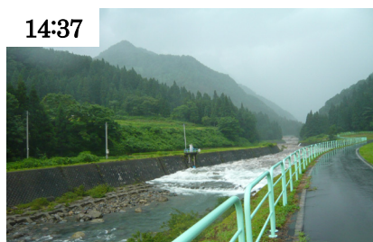
写真-2 高石川砂防堰堤下流
