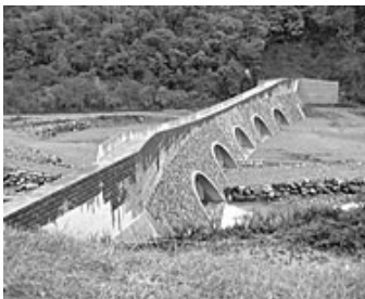
写真1：地獄平砂防えん堤
