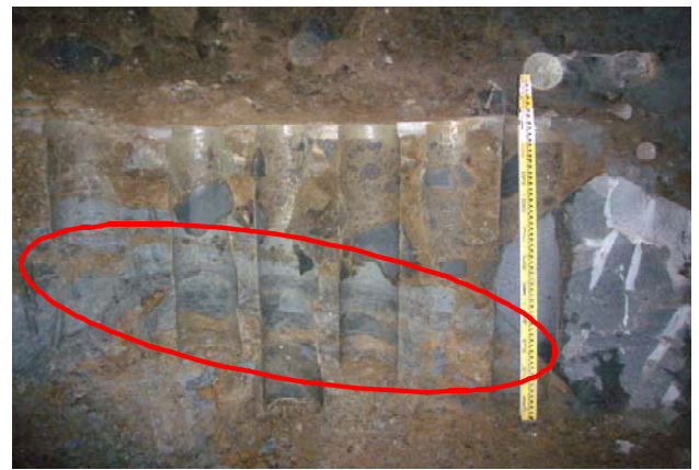
写真－1 サンプリング後の壁面状況 （蜂ヶ沢ブロック：○部分想定すべり面）
