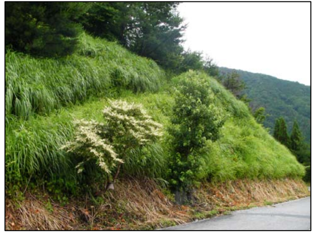
写真.1 施工後20ヶ月経過
