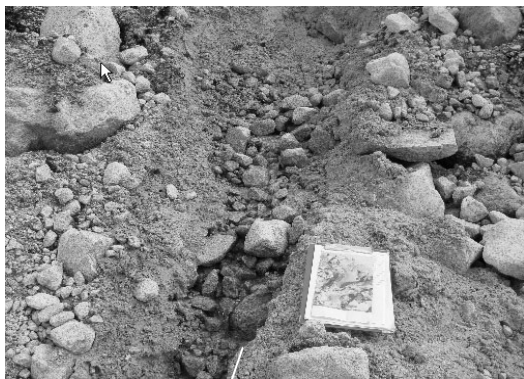
写真-3 左岸モレーンからの水のしみ出し
