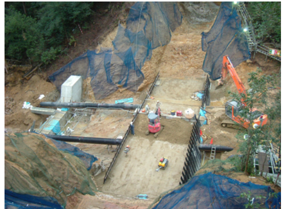
写真-2 砂防ソイルセメント施工
