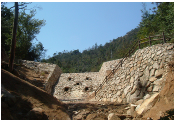
写真-3 1号砂防えん堤下流面
