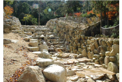
写真-4 2号砂防えん堤
