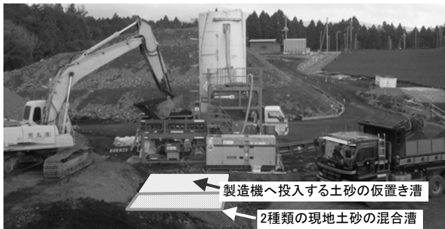
図 2 INSEM 製造機の土砂混合槽，仮置き槽
