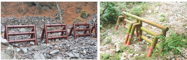
写真-1 コンクリート基礎を持たない構造物例
