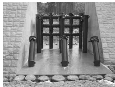
写真1 前期施工完成時
