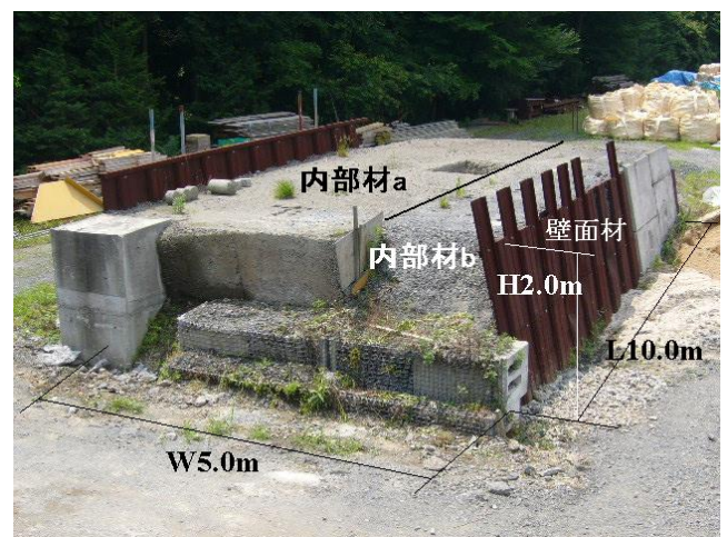
写真-2 袖部試験堤体
