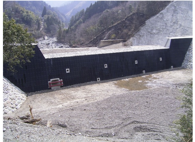
写真-1 砂防ソイルセメントを活用したえん堤の構築例
