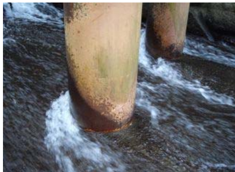
写真2 常時流水を受けている鋼管根元(波田黒川)
