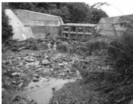
写真-1 礫と流木が混合した状態での捕捉状況
