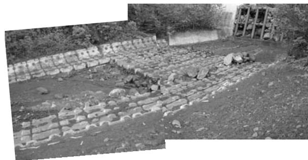
写真-3 本えん堤の下流側堆砂状況
