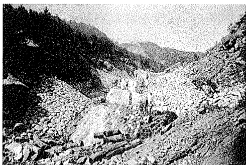
写真-4 完成状況
