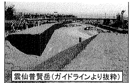
写真・2 導流堤の設置例
