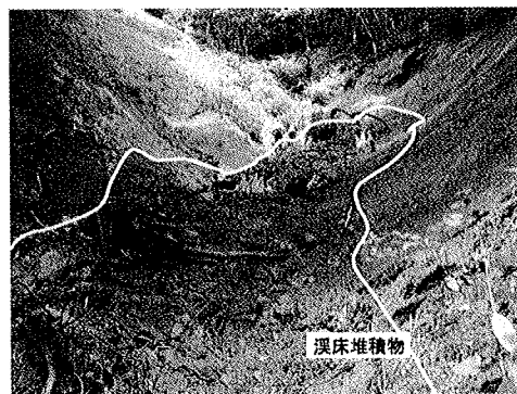
写真-1 土砂の堆積状況
