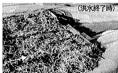
写真4 閉塞型流木捕捉状況2
