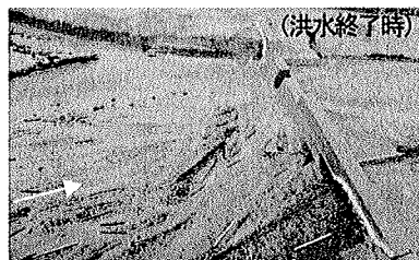
写真2 堰上げ型流木捕捉状況2
