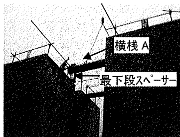
写真5 溝内の横棧Aの角落とし
