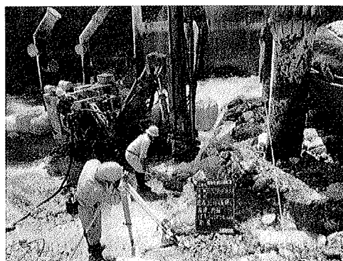
写真2 底版コンクリートのはつり状況
