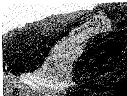
写真-1 応急復旧後状況
