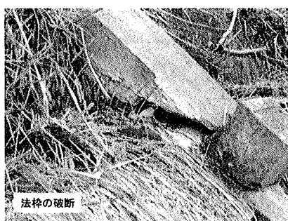
写真-1 地すべりによる変状
