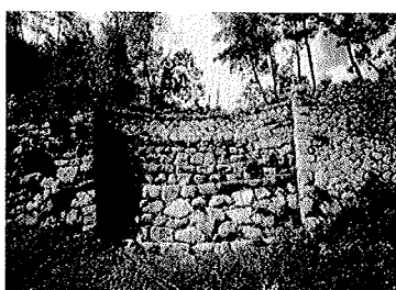
写真3 圭峰砂留 旧福山藩 (現福山市)
