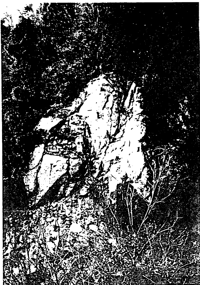
写真1 芦屋川右岸（道アゼ谷川合流点より80m下流）の岩石崩壊。
