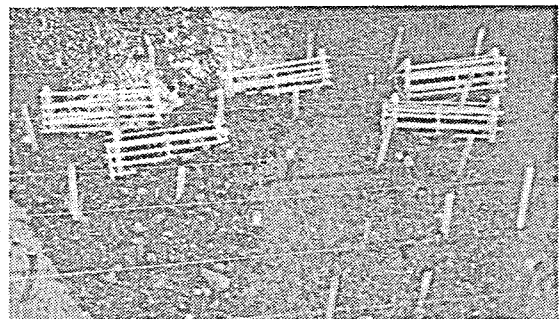
写真-1 フェンスによる土砂の捕捉状況
