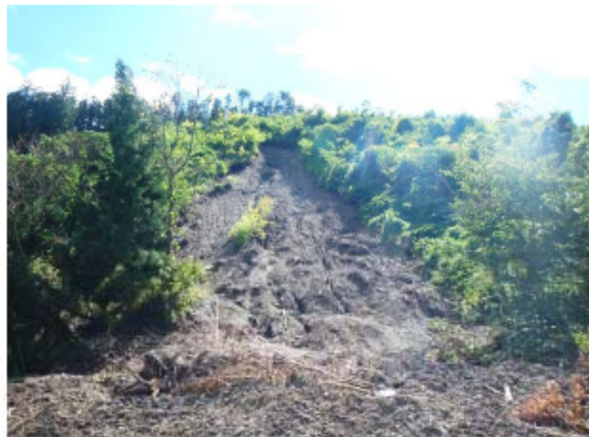
写真6 崩壊規模 L=60m, B=20, 崩壊深1m, 傾斜 \approx 40^\circ
