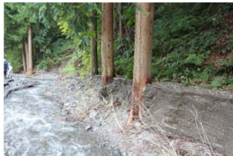
写真11 土砂埋積後の再侵食によって樹幹の一部が 露出したスギ。 樹幹に大きな損壊がないことから衝撃力の強い土石 流は発生していないと考えられる。
