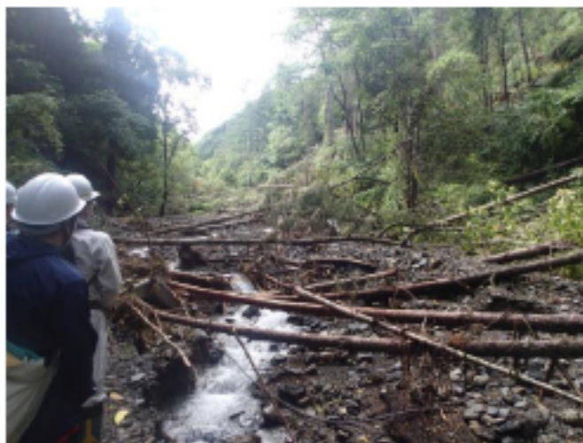
溪流内の状況(中流域)
