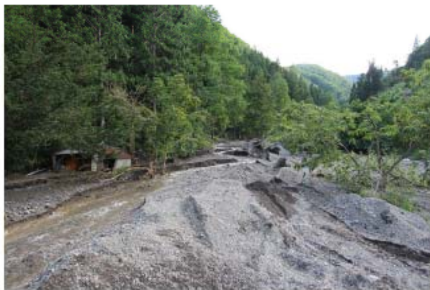
写真10 褰綿(ほろわた) 田畑地区の沢における土砂 流出状況
