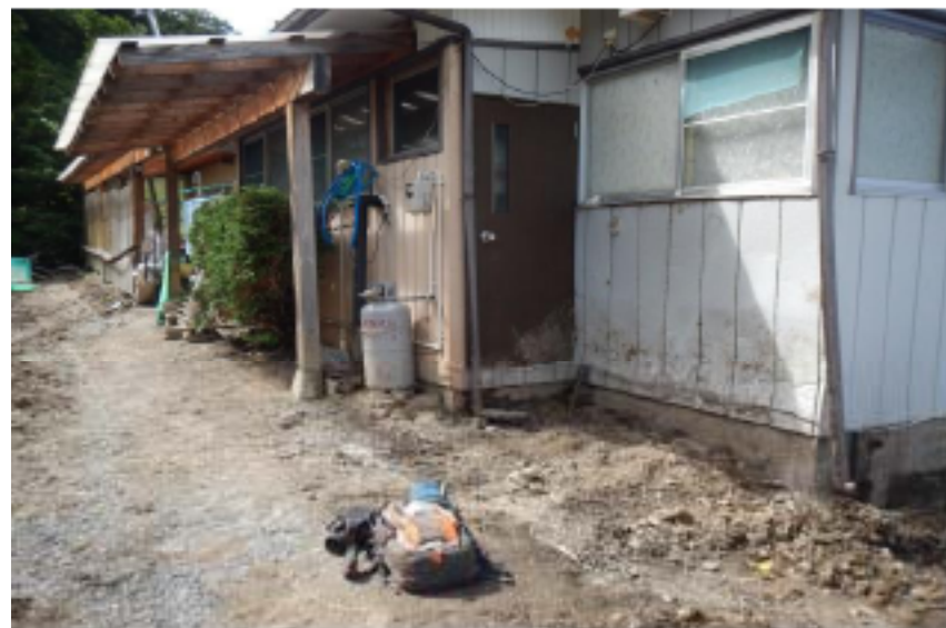
写真7 崩壊地下の保全対象人家
