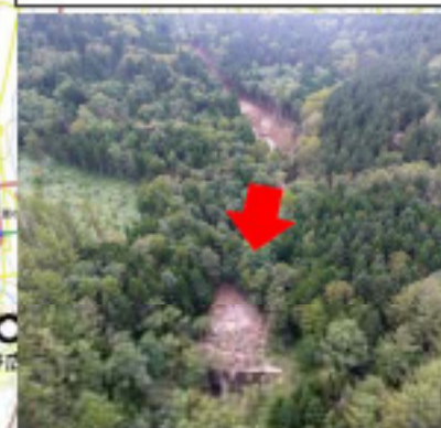
落合3の沢(北海道空知郡南富良野町落合) 土石流等 施設効果事例
