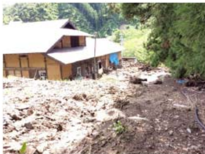
写真4 家屋への土砂氾濫状況
